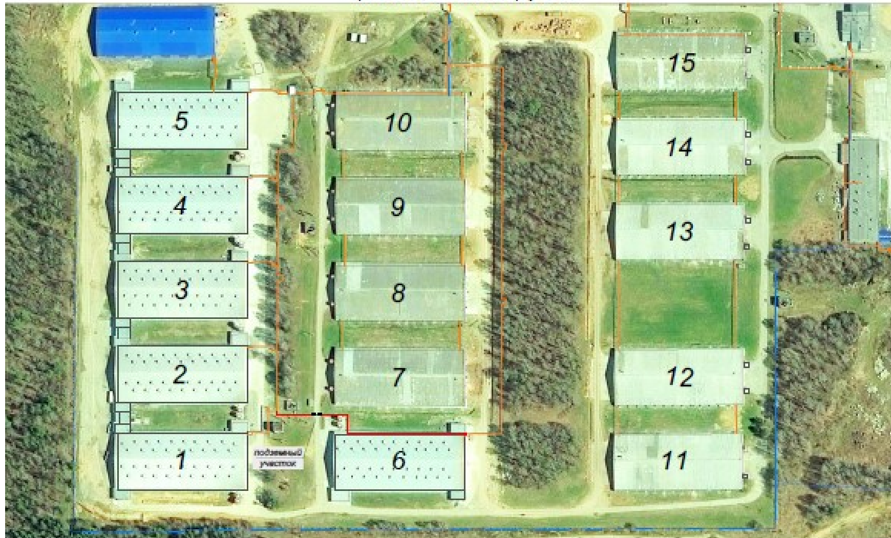
Цех бройлеров №2 прокладка теплосети до корпуса №10
